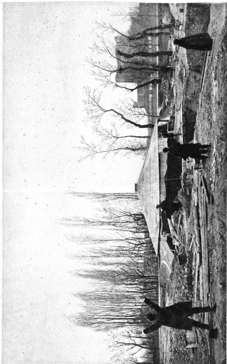
Fig. 463. — Sondage de Montrond. Jaillissement observé en février 1885. Le jet dépasse le cadre de la figure d'une hauteur à peu près égale à celle qu'on a représentée. *O*, orifice d'un mètre carré qui livre passage au jet d'eau gazeuse *JJ*, *e e* ruissellement de l'eau tombée sur le toit *T* tranchée exécutée pour le captage. — D'après F. Laur.
