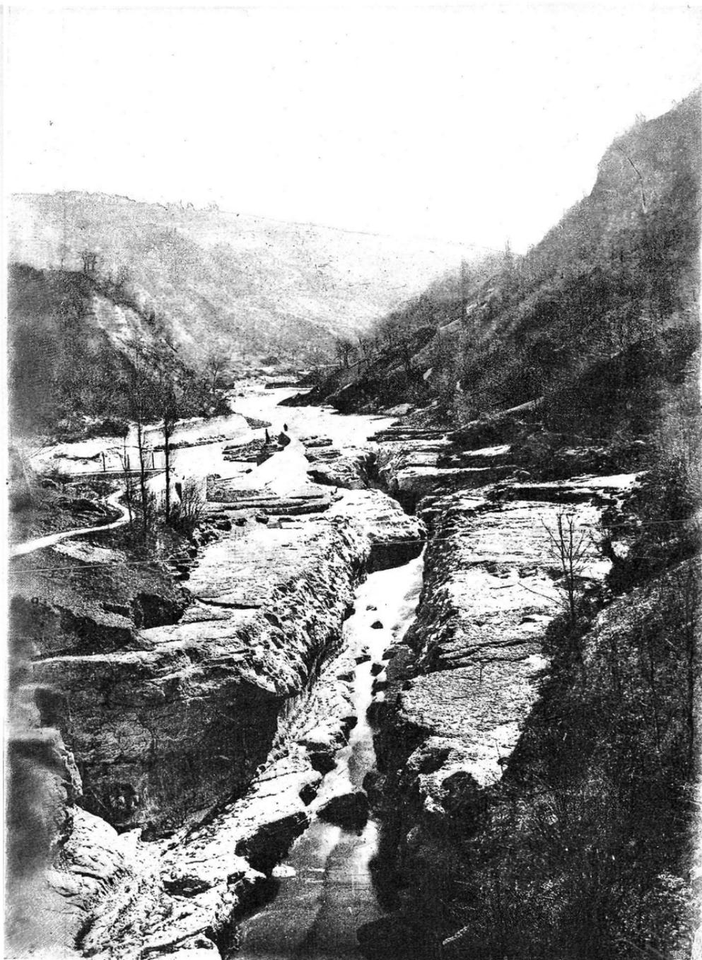
Fig. 139. — Vue de la perte du Rhône à Bellegarde, prise du milieu du pont de Lucet. On voit, sur la rive droite du fleuve et vers le haut, un barrage qui a été établi pour la prise d'eau des turbines.
